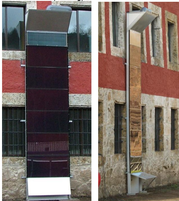
Chimenea solar fotovoltaica
