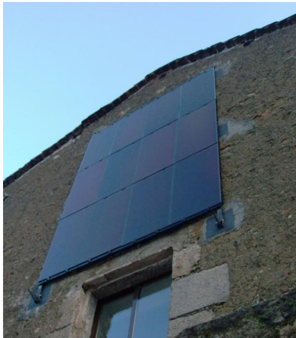
(b) condición de estancamiento
