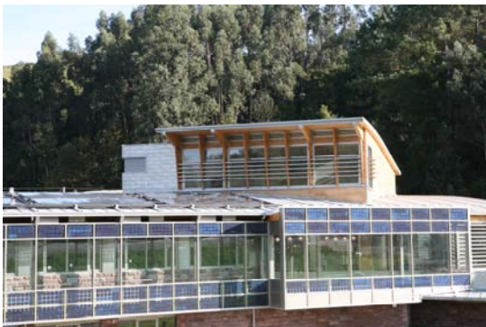
GALERÍA SUR Y SALA DE CONTROL
