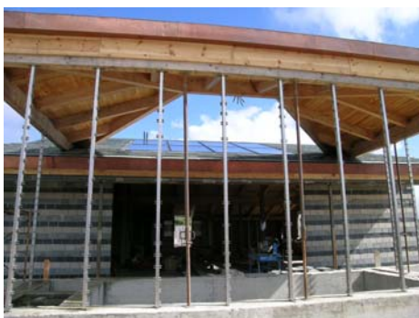
CONSTRUCCIÓN FACHADA SUR
