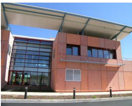
VISTA FACHADA SUR
